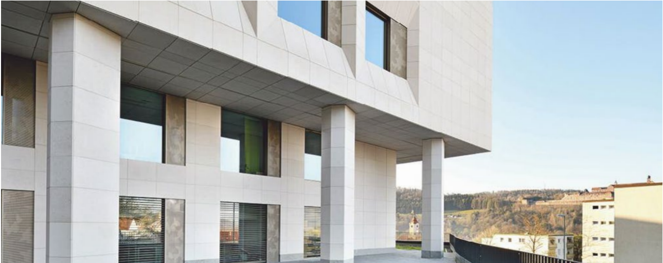
Neubau Klinikum Kulmbach – Fertigstellung 2024
